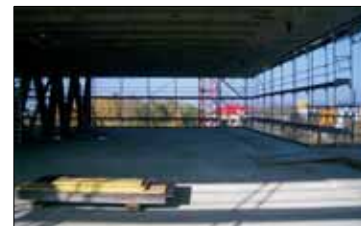
Weit auskragende Geschossdecken – freie Sicht
